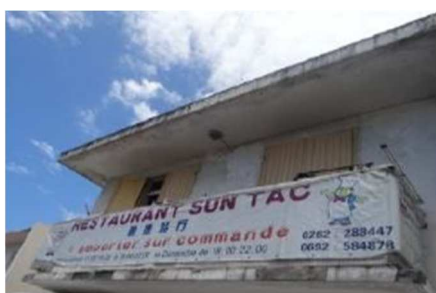
Enseigne installée sur balcon Rue Pasteur
