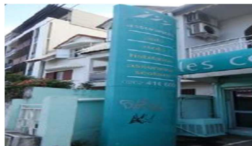
Enseigne scellée au sol non conforme au regard de la superficie maximale autorisée Rue d'après
