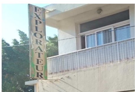
Enseigne drapeau non conforme au regard de la superficie maximale autorisée Rue Pasteur
