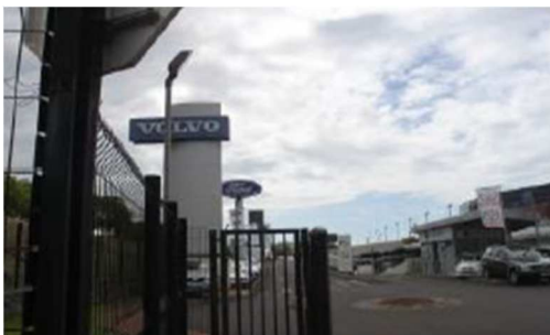
Enseigne scellée au sol non conforme au regard de la superficie maximale autorisée Chemin Grand Canal
